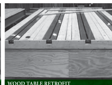
WOOD TABLE RETROFIT
