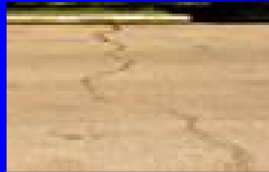
Longitudinal cracking
