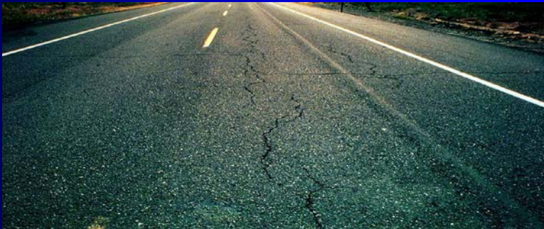
Longitudinal Cracking
