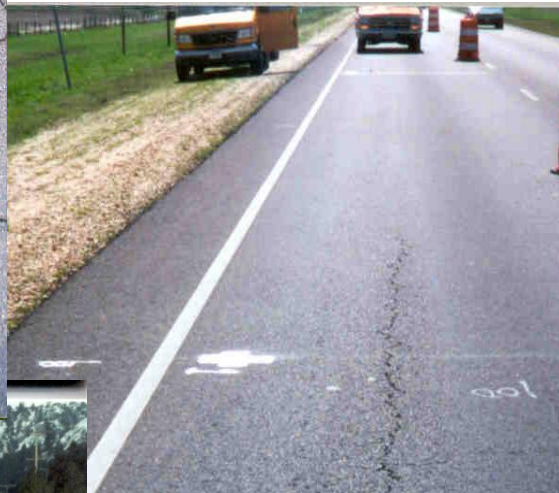
Longitudinal Cracking
